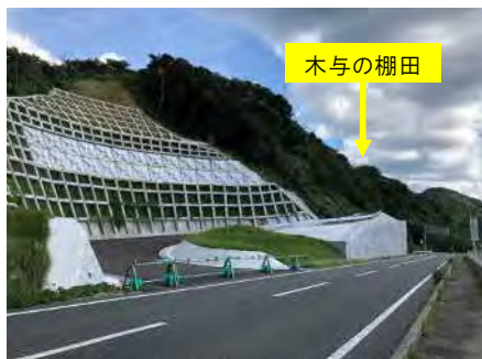
写真-1 工事用道路②起点側
