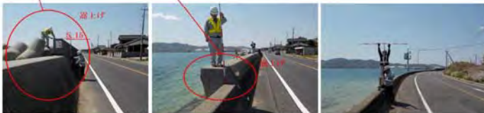
現地状況写真
