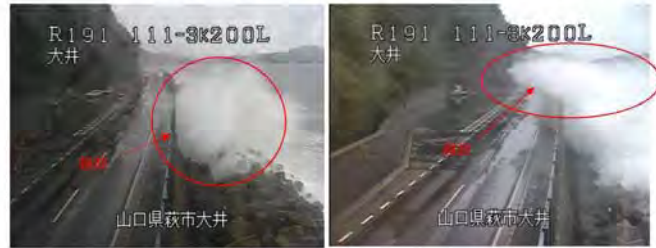
台風17号による越波(打上げ)状況_令和元年9月23日7時頃
