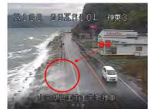
神東地区越波状況
