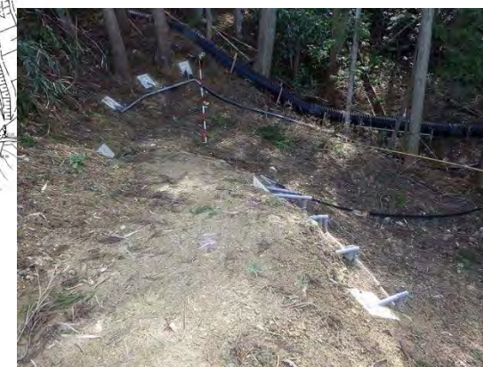
② 応急水抜きボーリング工
