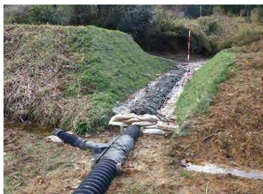
③ 浸透防止工(ため池開削)
