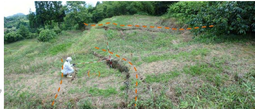
③ 頭部～側方部に連続する滑落段差
