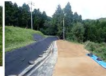
応急対策としての浸透防止工
