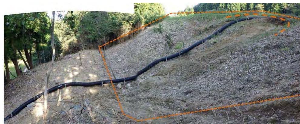
⑫ 既16ブロック 排土工(H14施工)
